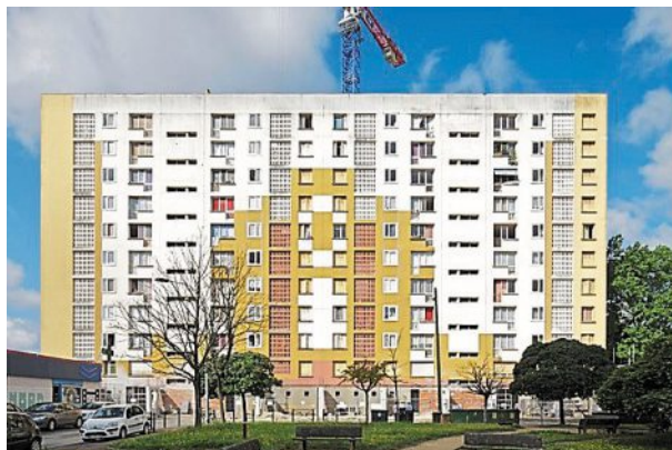
Avant et après : la transformation du bâtiment H du Grand Parc, à Bordeaux.
