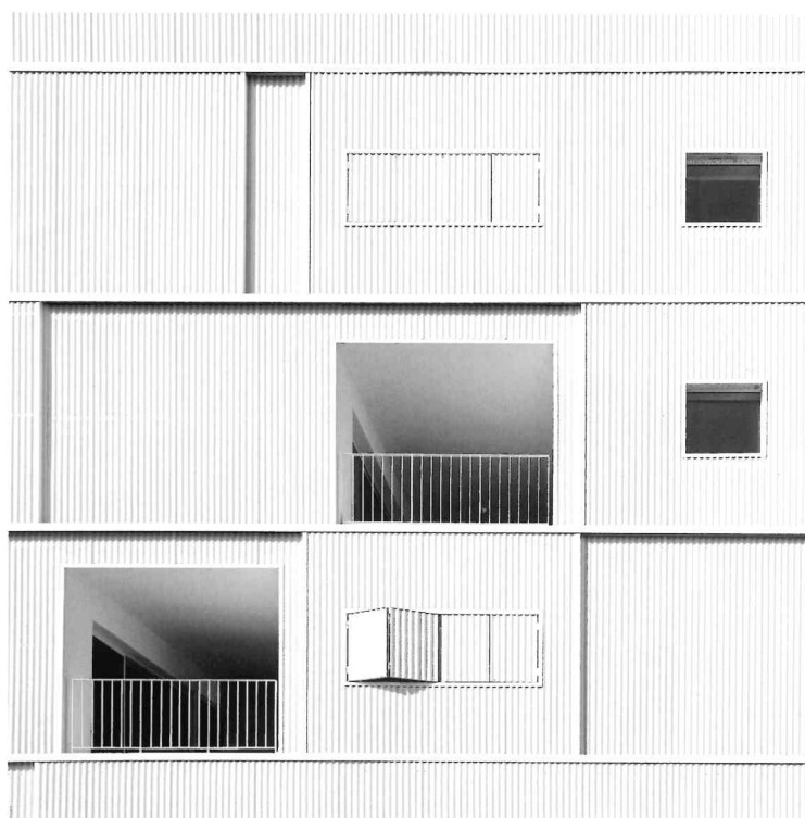
LAN, 79 viviendas sociales, Bègles
